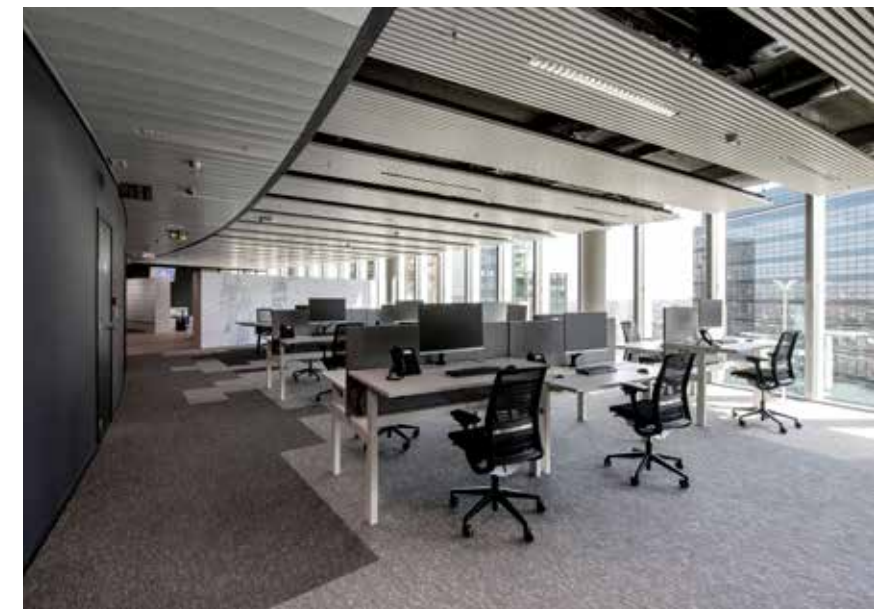
Het klimaatplafondsysteem met stralingswarmte vormt een energetisch en akoestisch optimum. En quasi alle werkplekken genieten van een riante natuurlijke lichtinval.
