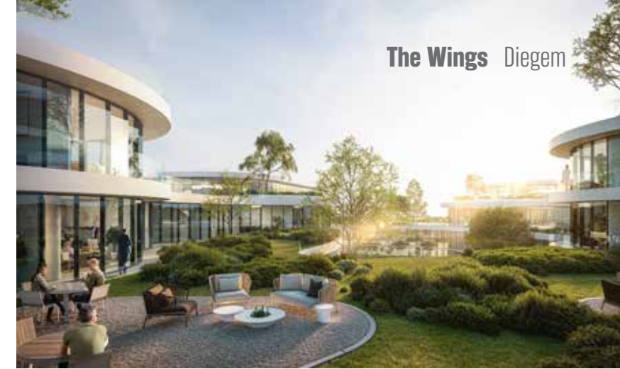
De gevels hebben afgeronde hoeken en bestaan voornamelijk uit glas en horizontale geledingen in een voorgevormd lichtgrijs plaatmateriaal.
