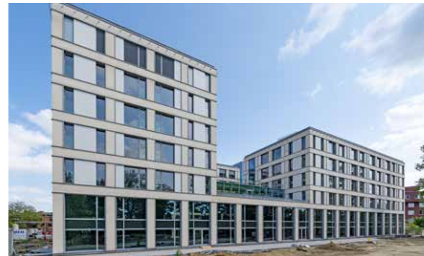
De bouw van de E-vleugel kadert in de realisatie van het masterplan Jos Van Geel, dat de campus van AZ Monica omvormt tot één compact geheel.
