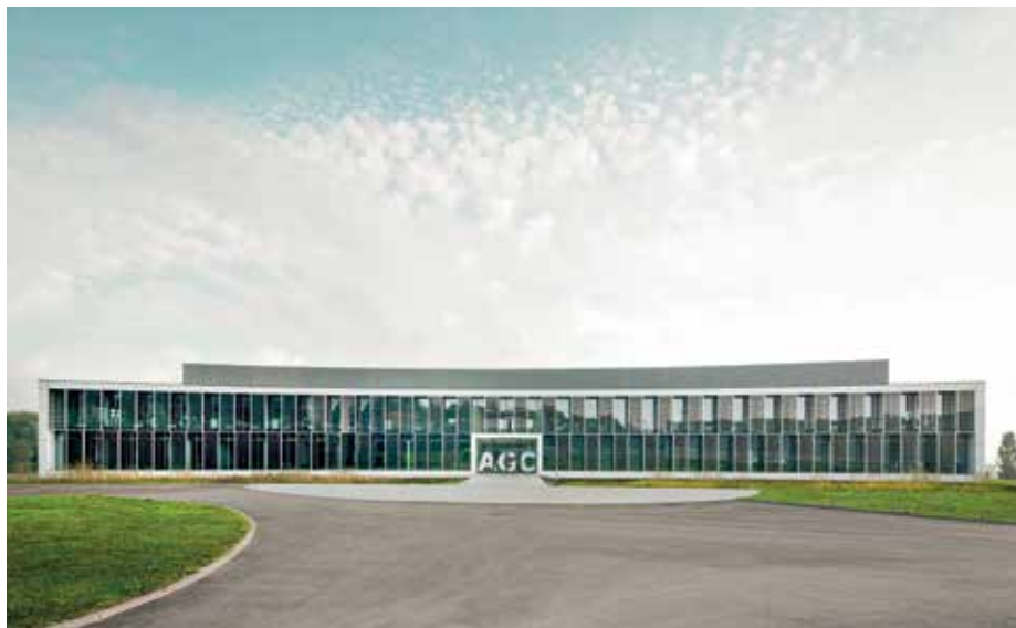
Le Technovation Centre d'Agc à Gosselies.
