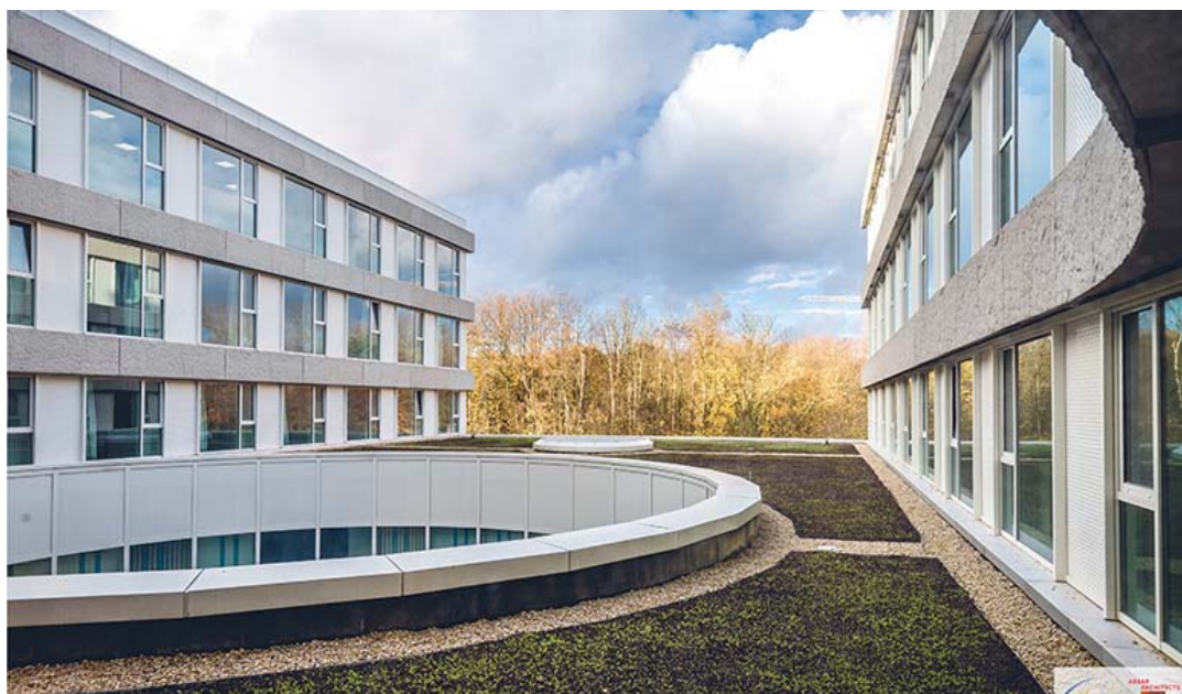
Een deel van de daken is als groendak afgewerkt. (beeld: Marc Detiffe)
